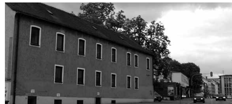
In der Lutherkirche steht ein größerer Umbau an. Deshalb muss das Pfarramt vorübergehend ins Gemeindehaus auf der gegenüberliegenden Straßenseite umziehen. Der Umzug wird vom 9.7. bis 13.7. sein. Fotos: Sabine Paul
